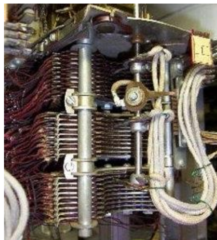
Selector de elevación y giro (100 salidas)
